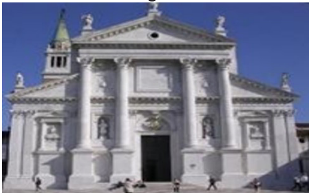
Frontões e a cúpula, essa ladeada por singulares torre tipo “minarete” de Andrea Paladio
